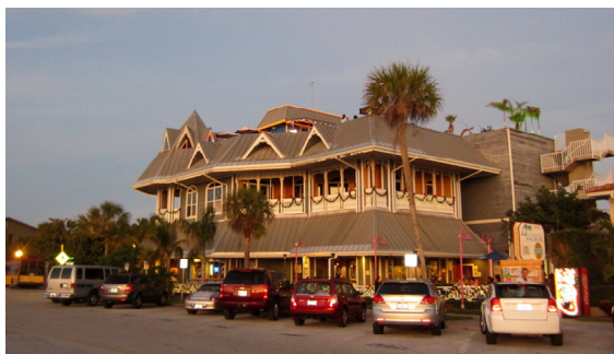
Takterrassen på "The Hurricane" blev en favorit
